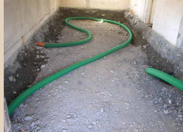
ERNEUERUNG ERDBERÜHRTER BAUTEILE
