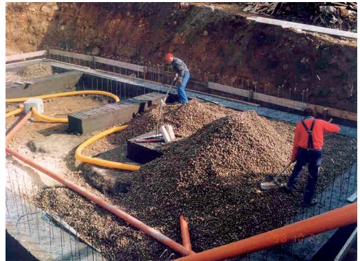
Einbau einer Radondrainage in Kies beziehungsweise Schotter
